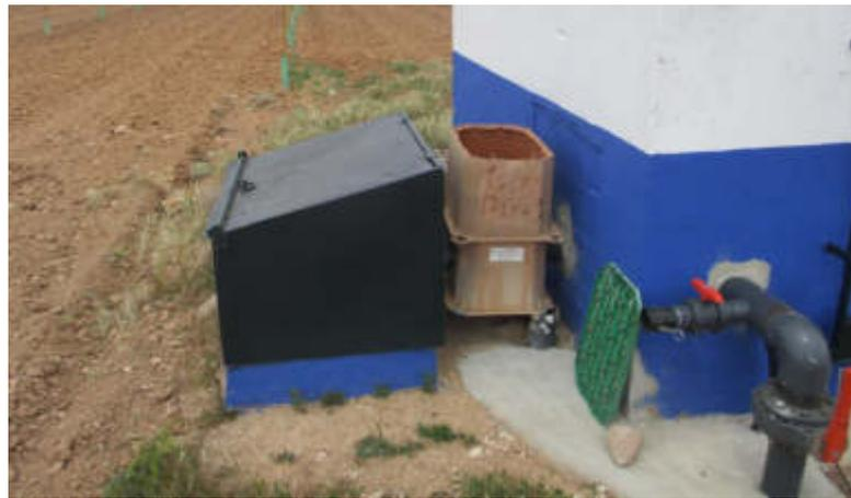
Figura 4.1. Correcto. Captación en arqueta cerrada Contador en arqueta abierta anexo a caseta de riego. Si es necesario, se puede requerir la presencia del titular para que abra la arqueta del pozo.
