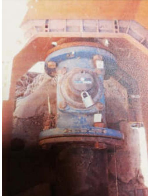
Figura 7.1. Contador inaccesible. Candado en la propia tapa del totalizador.
