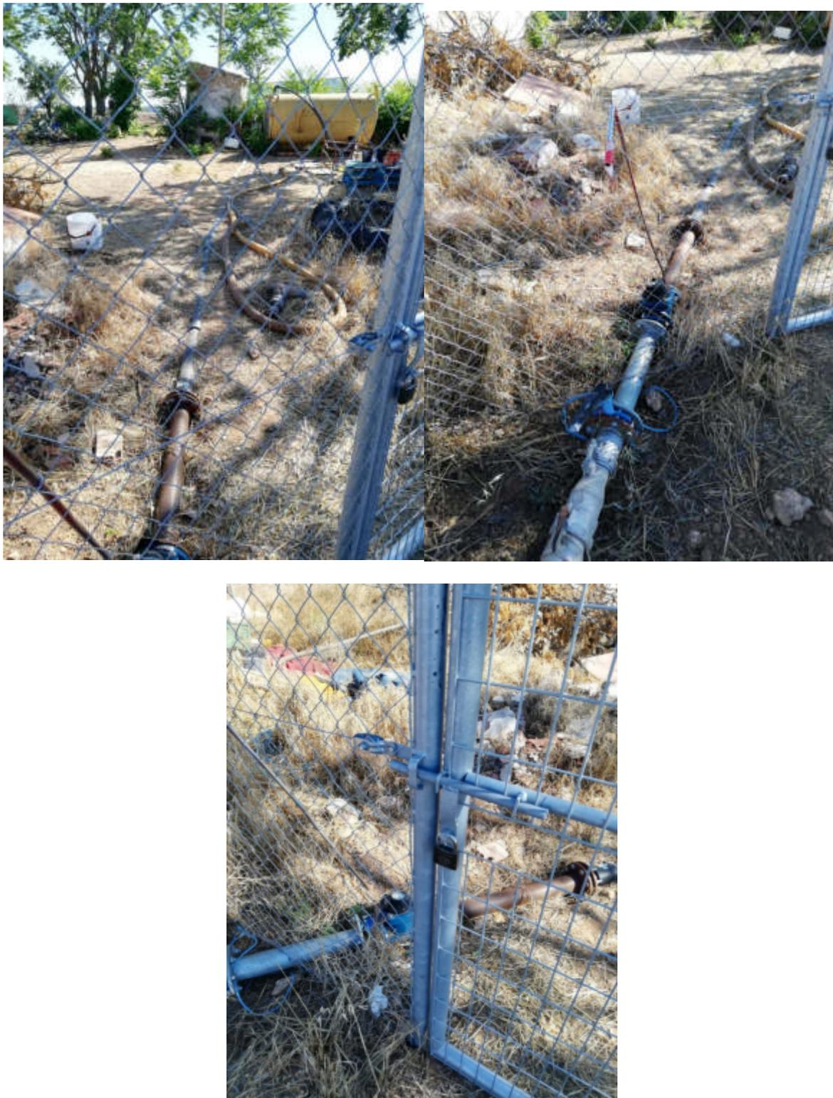
Figura 5.5. Correcto. Contador dentro de vallado. Tubería entre pozo y valla visible. Contador visible desde el exterior.
