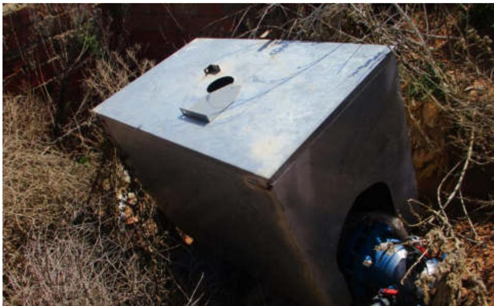
Figura 3.6. Correcto. Arqueta con visor. Hay que comprobar que el tamaño y ubicación es el adecuado para poder realizar las comprobaciones oportunas.
