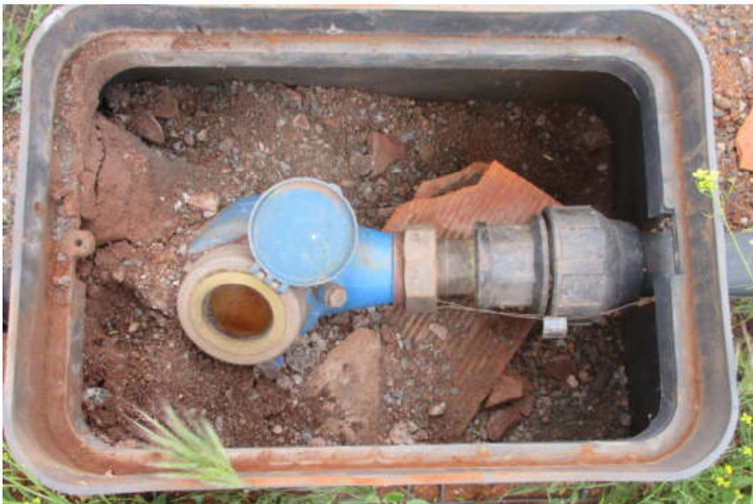
Figura 7.4. Contador en mal estado. Esfera ilegible.
