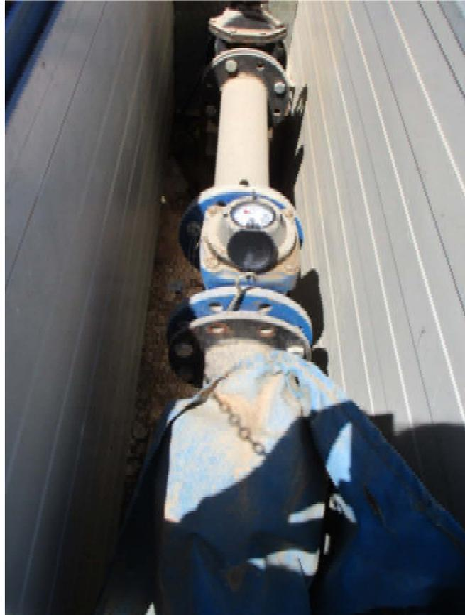
Figura 7.3. Trapos, sacos y demás, que no deben cubrir el contador dentro de la arqueta que impida ver a través del visor.
