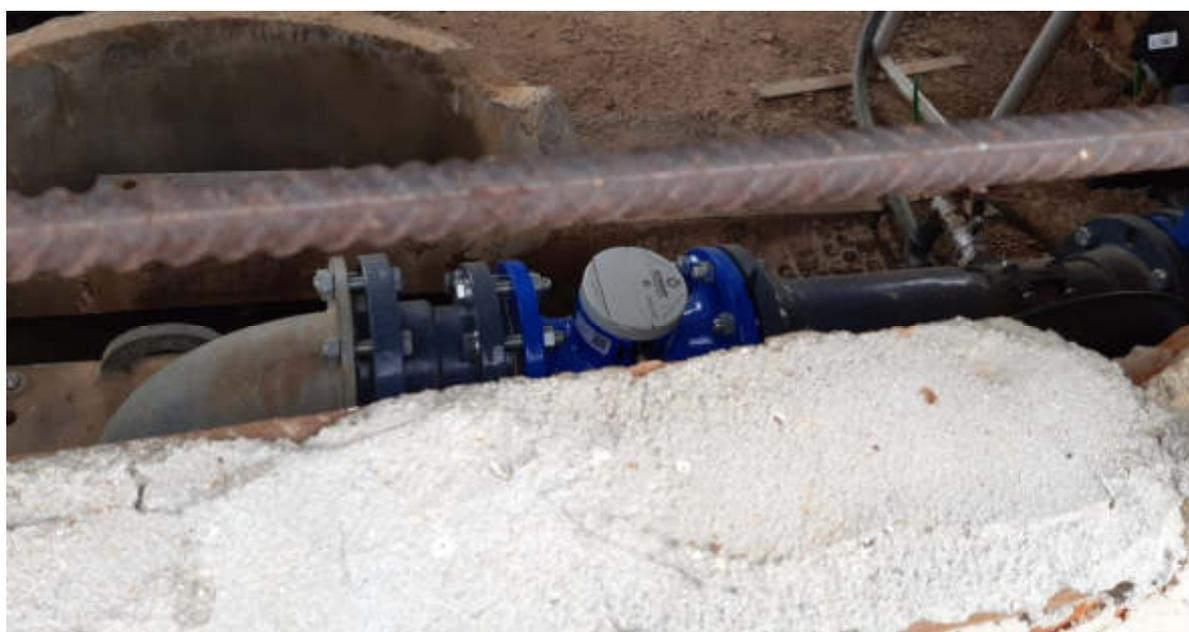
Figura 4.7. Incorrecto. Como desde fuera no se puede levantar la tapa, la misma debe quedar abierta. Ver imagen siguiente.
