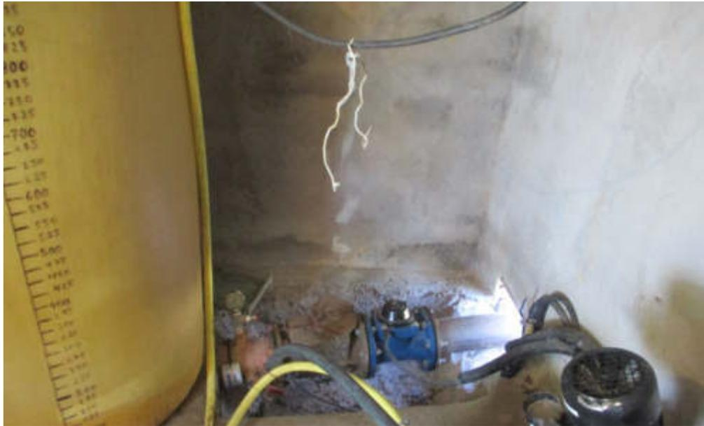
Figura 4.5. Incorrecto. Contador en el interior de caseta, existiendo tubo pasante. El contador puede quedar en el exterior.
