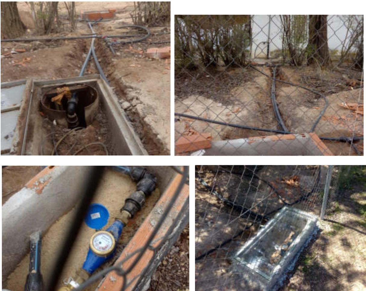
Figura 5.4. Correcto. Contador dentro de vallado. Tubería entre pozo y valla. Hay que asegurarse de que el contador queda instalado en la dirección del flujo. Tapa de policarbonato en arqueta
