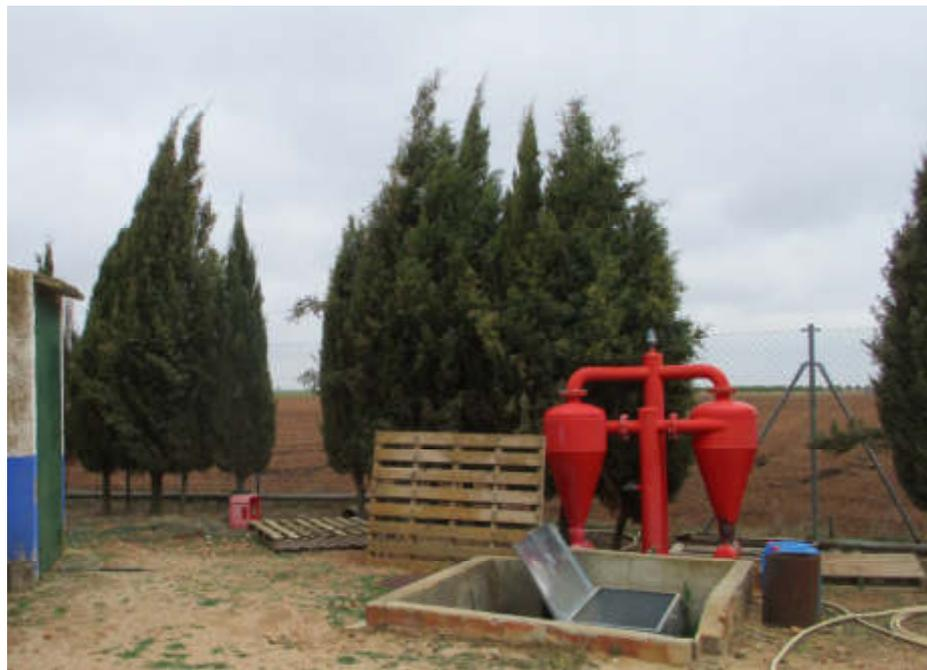
Figura 5.6. Incorrecto. Contador dentro de vallado y en arqueta bajo nivel de suelo. Inaccesible desde el exterior. Se puede sacar mediante tubería o hacer pasillo en la valla perimetral
