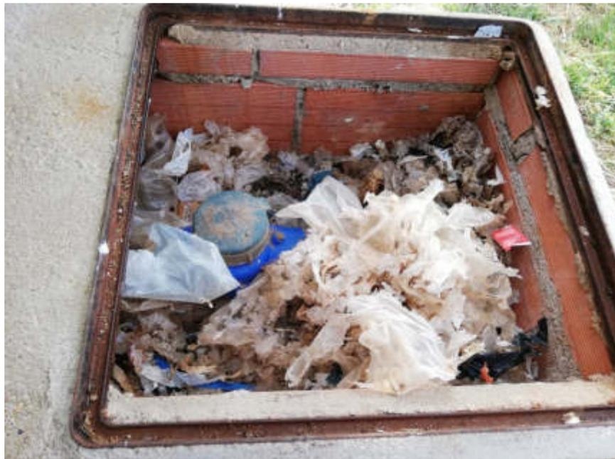
Figura 2.1. Contador en arqueta con nido de ratones. Estado tras retirar parte de la suciedad
