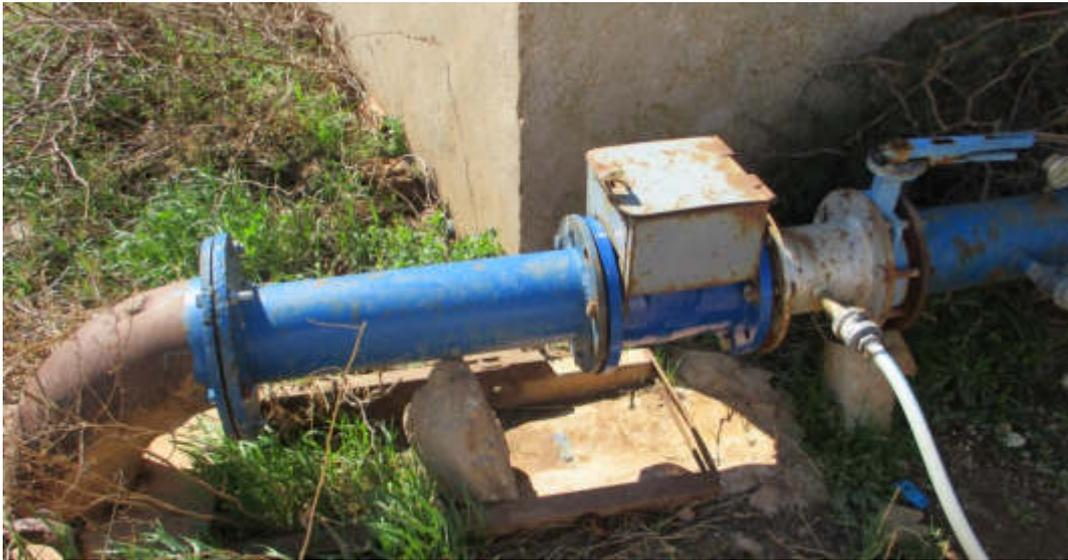
Figura 3.2. Instalación incorrecta. Arqueta que no protege el contador. Tiene el objeto de impedir tomar la lectura e inspeccionar el contador.
