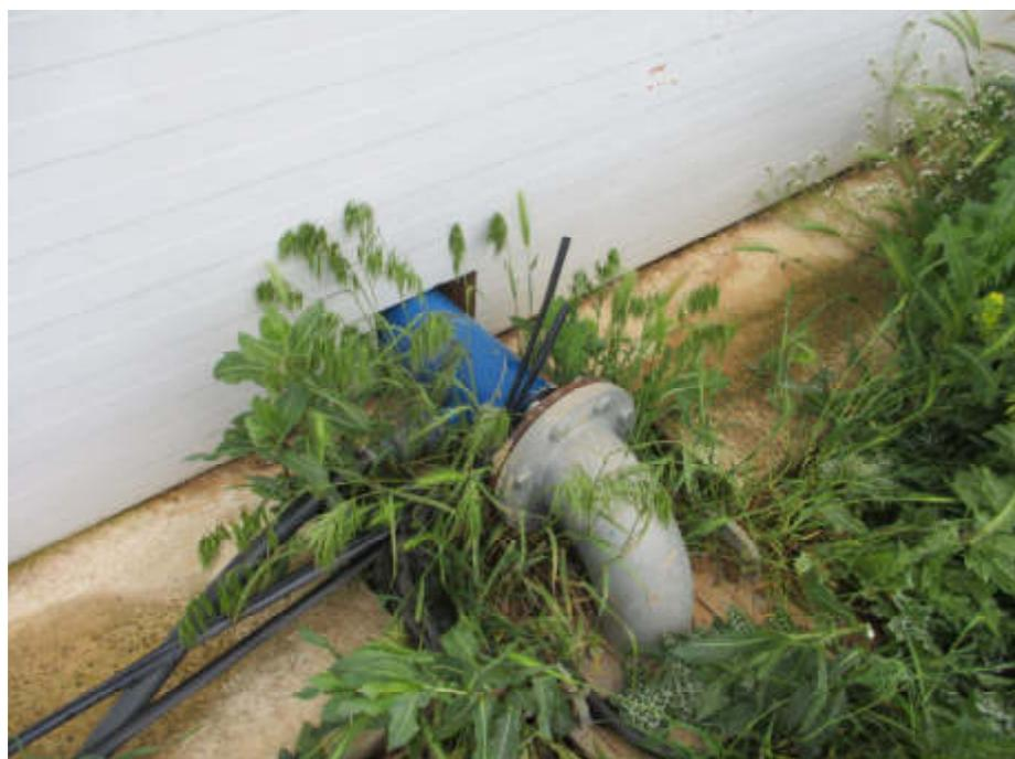
Figura 4.4. Incorrecto. Tubo pasante, el contador se puede situar en el exterior. Máxime cuando la captación está fuera de caseta.
